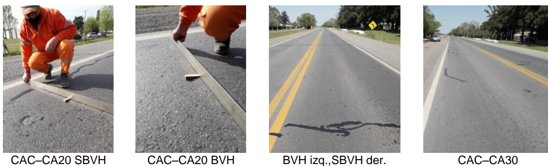
Figura 21. Estado de los tramos a los 22 meses
