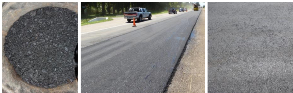
Figura 10. Aspecto de la mezcla CAC–CA20+BVH
